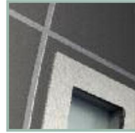
Edelstahlstreifen bilden flächenbündig mit der Glasoberfläche und der Aluminiumfüllung eine Einheit.
