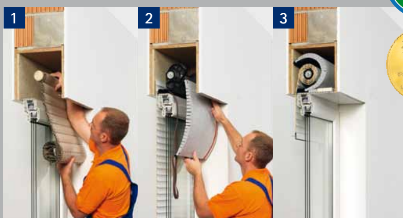
1 Alten Rollladen aus Kasten entfernen!
