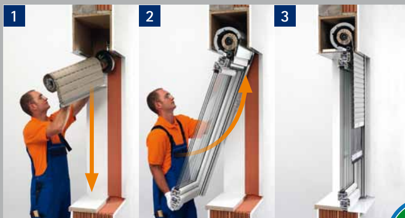
1 Alten Rollladen aus Kasten entfernen!
